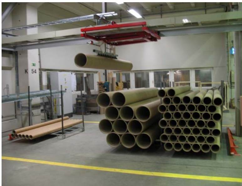
Installation hos Korsnäs AB, Gävle. Klarar olika hylsdiametrar och utseende på pallar utan omställning.
